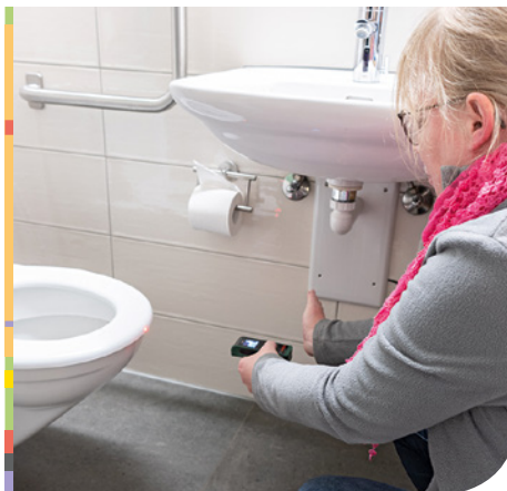
Auch die Behindertentoiletten sind sehr unterschiedliche gebaut. Details wie der Abstand zwischen Waschbecken und Toilette können einen grossen Unterschied machen
